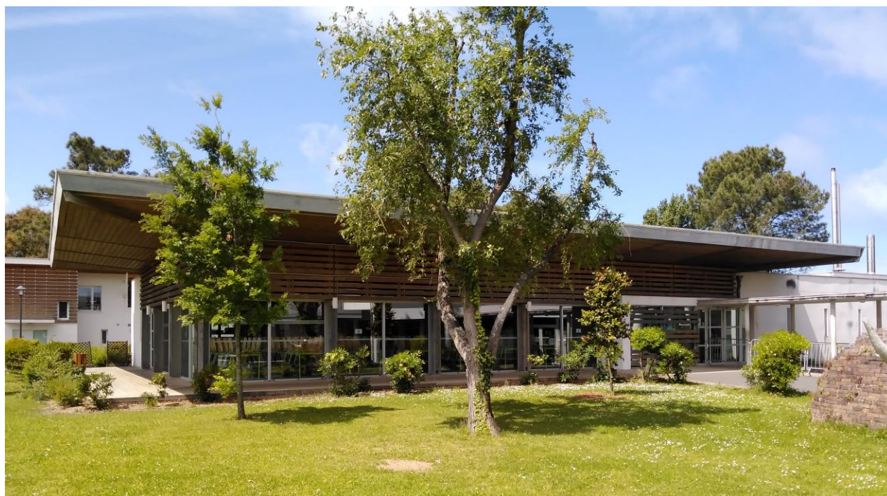
Le bâtiment du restaurant scolaire
